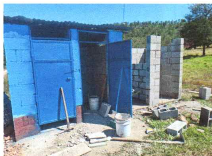
Foto 2: Instalando en paredes de baños azulejo y dando reforzamiento
