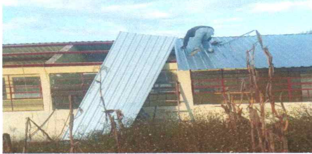
Foto1: Instalando cubierta de lámina
