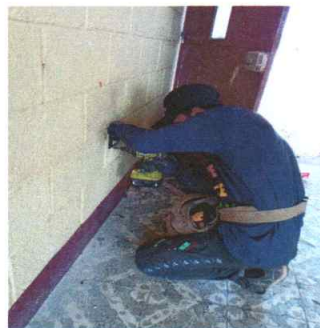
Foto 4: Instalando sistema eléctrico nuevo
