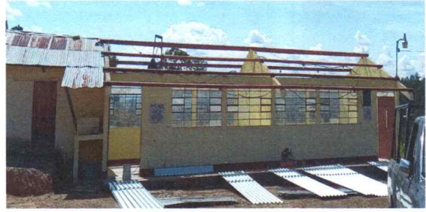
Foto 2: Aplicando mantenimiento a estructura de soporte de metal
