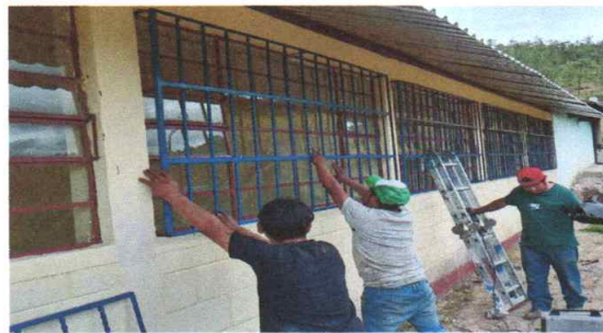
Foto 4: Instalando balcones y vidrios en ventanas
