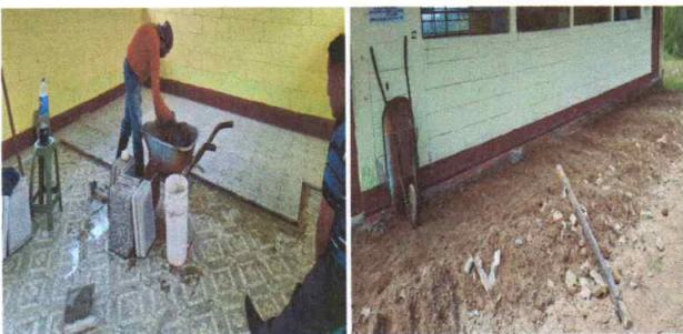
Foto 5: Instalando piso de granito en aulas y corredor
