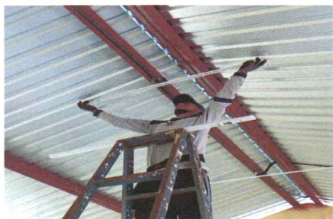
Foto 3: Instalando sistema eléctrico nuevo
